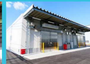
温度管理ができる危険物倉庫
