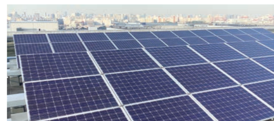
東京支店・平和島ロジスティクスセンター
