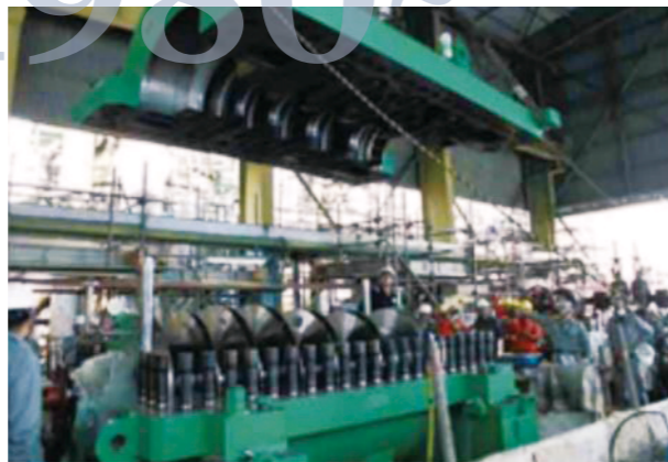
海外でのコンプレッサ据替メンテナンス工事
